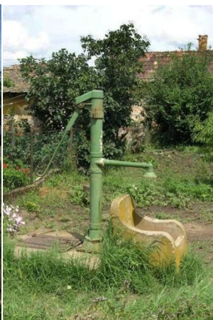
101. ábra – kéziszivattyús artézi kút Puzstamonostoron
