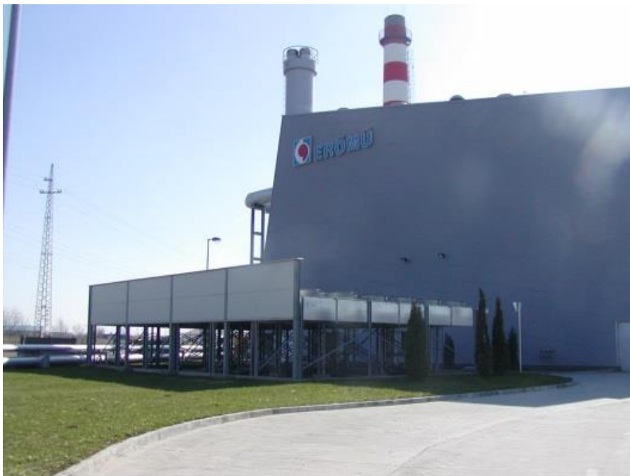
12. ábra Győrhő gázmotoros erőmű kényszerhűtő zajárnyékoló elemekkel
