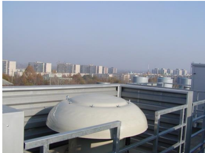
15. ábra Tetőventilátor zajcsökkentése a FŐTÁV Rákoskeresztúri Fűtőmű gázmotoros erőmű épületén
