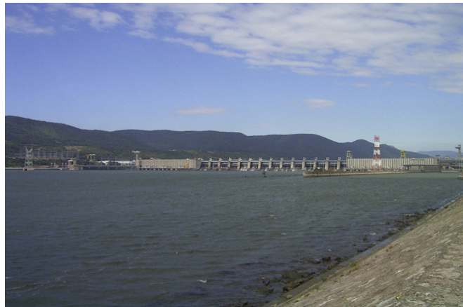
3. Vaskapu I. erőmű forrás: Wikipédia
