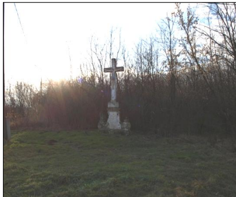
3. ábra Cserőhalmi kálvária, leromlott állapotban a délnyugati kapuban
