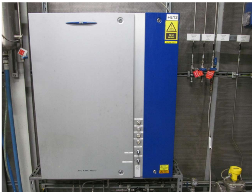
3.23. ábra: KMA 4000 hajtóanyag kondicionáló berendezés
