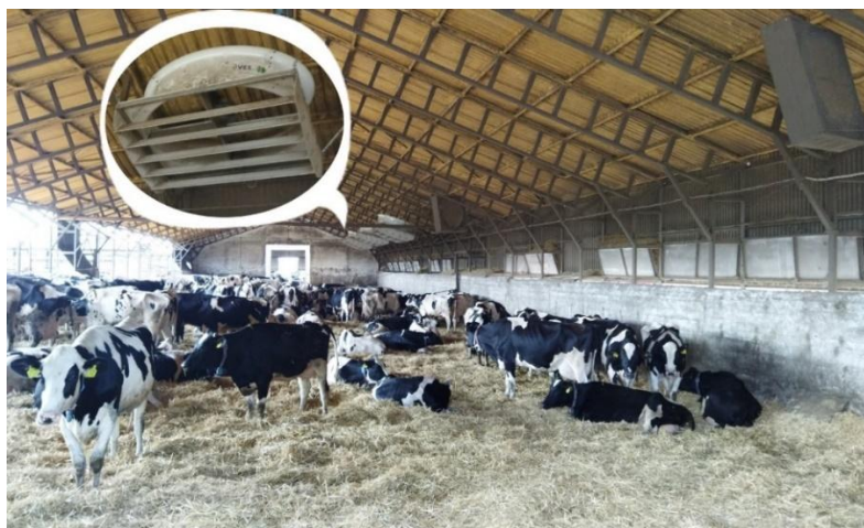
6. kép: Az új ventilátorok beszerelése az 1 B istállóban Fotó: Szalai Szilvia
