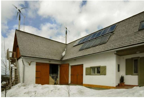
Figure 41. Low speed wind turbines in Renewable Energy Centre, Hárskút, Hungary. ( Hárskúti Megújuló Energia Központ 2007).
