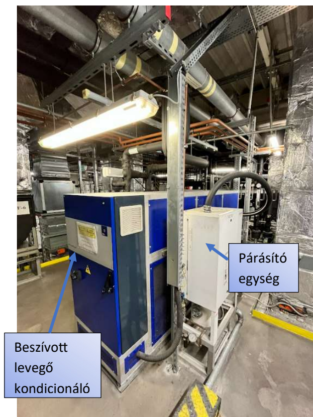
3.4. ábra Töltetlevegő előkészítő egység (Forrás: Biró Norbert)
