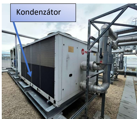
3.3. ábra. Hűtőkör kondenzáló egység (Forrás: Biró Norbert)
