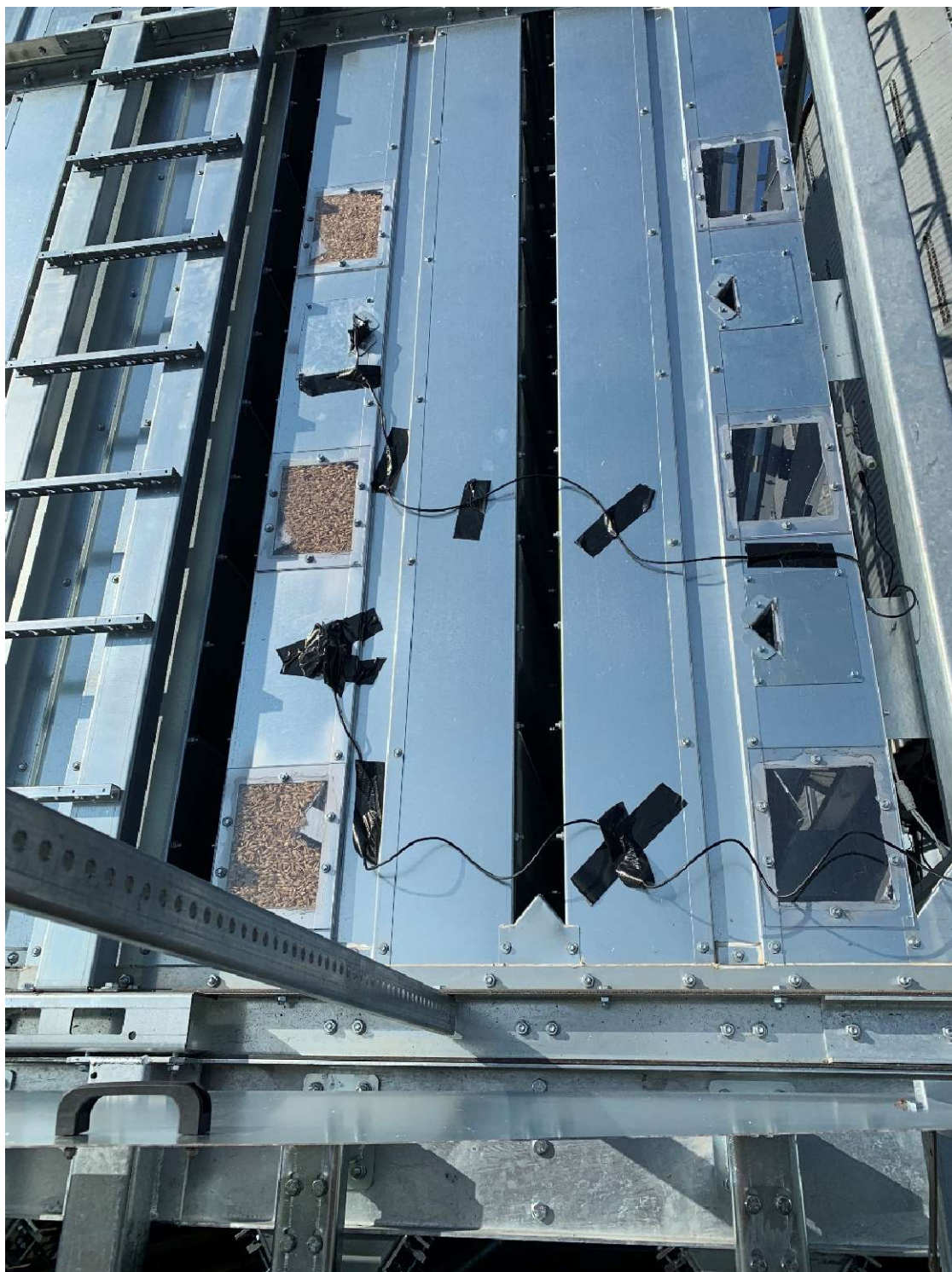
3.4. ábra: Betekintő ablakok és endoszkóp kamera szondanyílások a szárító modulon
