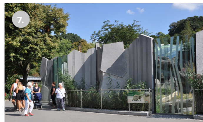
Az üveg felületkezelése révén a látogatói jelenlét kevésbé érzékelhető az állat számára és csökkenthető a területen élő madarak üvegnek ütközési veszélye.
