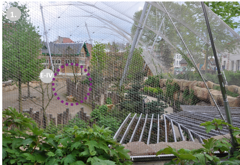
A társaskifutó a látogatói szinthez képest süllyesztett szinten létesült, így az új étterempérből nyíló kiemelt betekintőből nyíló térélmény nagyobb. Az acélháló lefedésű kifutó a műszikla által fedett támfalra talpal le.
