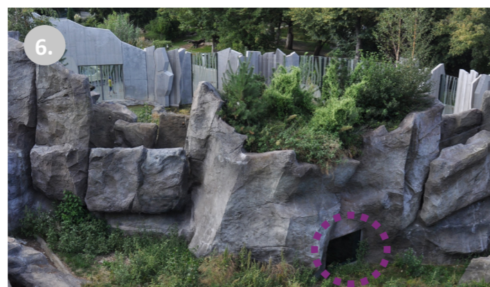
Elsődleges elhatárolási módként műsziklát alkalmaztak, melyben különböző perspektívákban üveglak betekintők létesültek.
